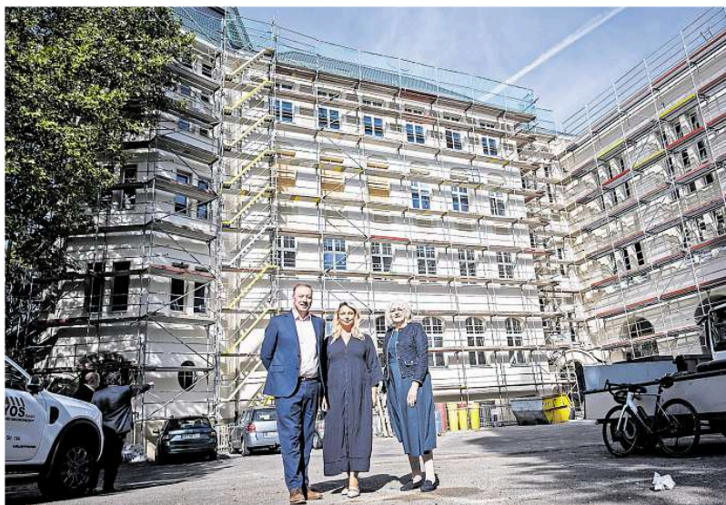
Die Sanierungsarbeiten am alten Comenius-Gymnasium schreiten schnell voran. Davon konnten sich Colm Rowan (künftiger Schulleiter), Annika Poestges (ISR-Marketing) und Eileen Lyons (Mitglied des Führungsteams) am Mittwoch überzeugen.
